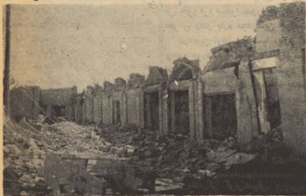
گوشه ای از خرابی های زلزله
