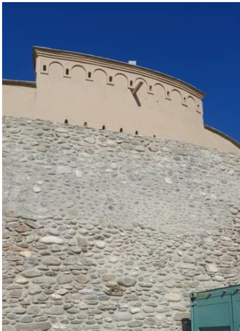
تصویری از قسمت بیرونی برج داخلی قلعه
