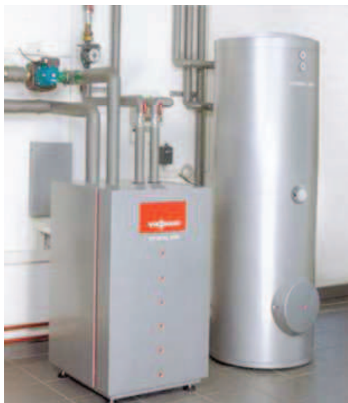
د فیسمن (Viessmann) د شرکت له خوا د جوړېدونکو حرارتي پمپو یوه نمونه
