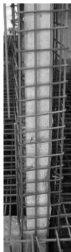
۱- شکل (اوسپنیز کانکریټي تخریب شوی
