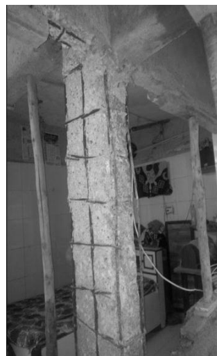
۱- شکل (اوسپنیز کانکریټي تخریب شوی
