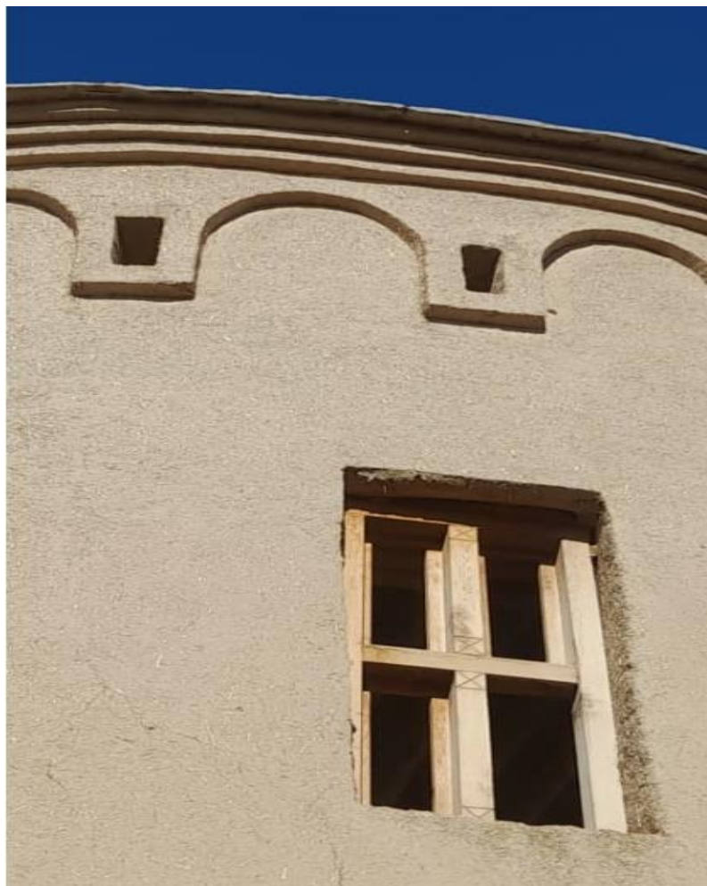
تصویری از قسمت برج های داخلی قلعه
